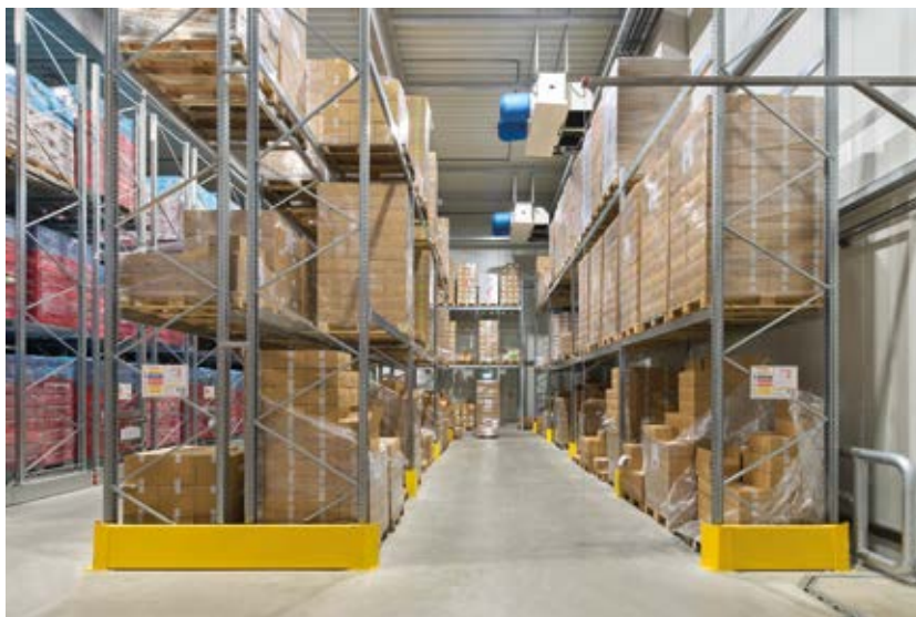
Brandschutz bei –26 °C: baulich gelöst, weil jedes Löschmittel einfrieren würde.
