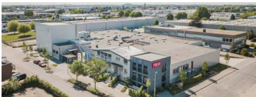
Mehr als 20 Kühl- und Tiefkühlräume hat Polat auf seinem Produktionsgelände in Mönchengladbach.
