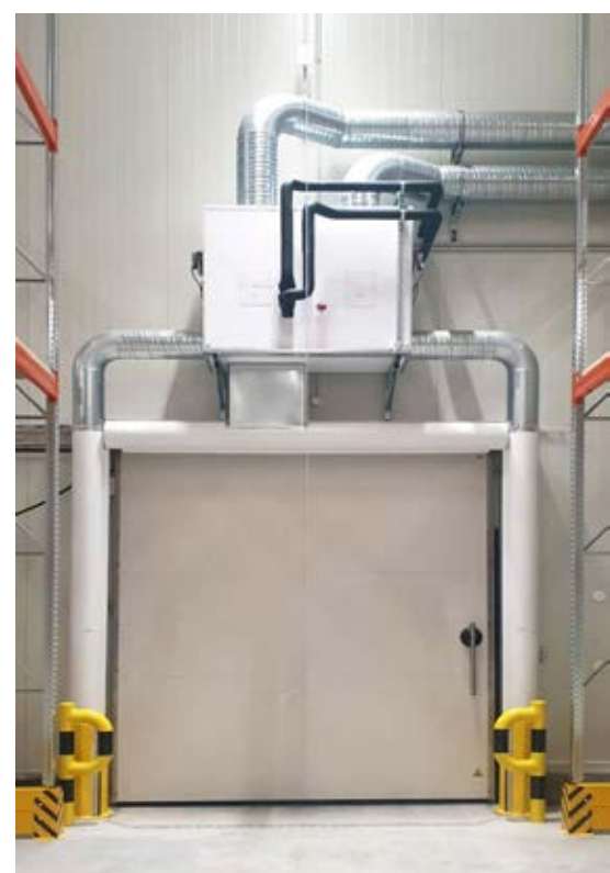
Luftschottanlagen können den Luftaustausch an stark genutzten Übergängen zwischen unterschiedlichen Temperaturzonen reduzieren.
