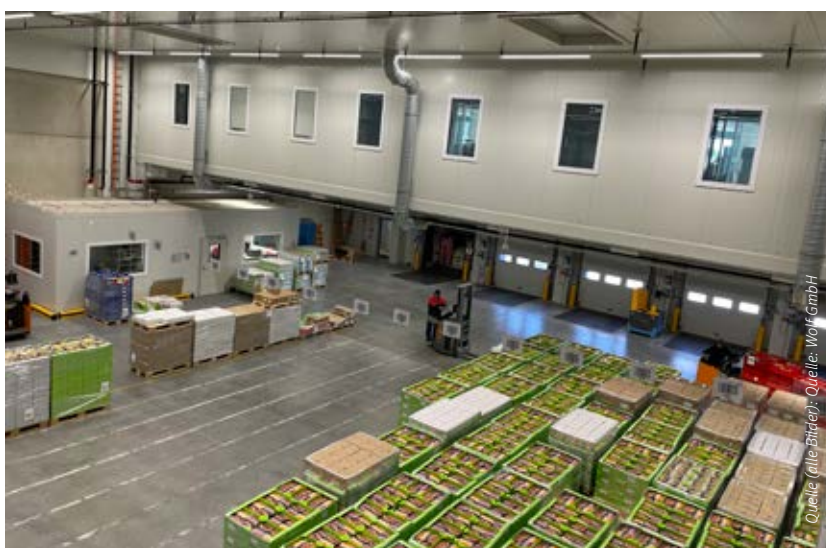
Im Kommissionier-Bereich der xxx von Bürger befindet sich oberhalb der Verladezone auch ein rund 1100 Quadratmeter umfassender Verwaltungstrakt mit Sanitärräumen.
