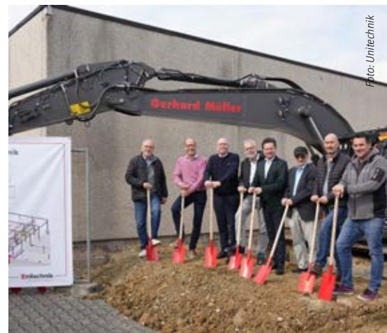
Beim Spatenstich in Wiehl (von links): Vladimir Musil, Architekt; Wolfgang Cieplik, Inhaber; Tors-ten Ley, Geschäftsführer; Dirk Panske, Projektleiter; Ulrich Stücker, Bürgermeister Wiehl; Heinz Poppek, Firmengründer; Rainer Poppek, Inhaber; Alexander Müller, Bauunternehmer.
