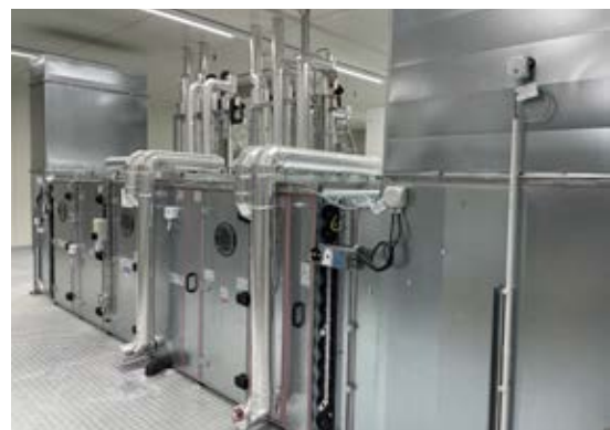
Wolf Umluftgerät zur reinen Temperierung ( + 8^{\circ}\text{C} ).
