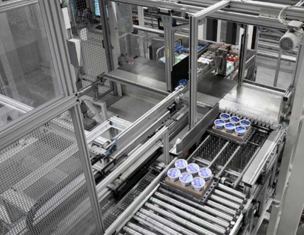
Das Logistikzentrum beliefert an einem Spitzentag über 725 Filialen in den Niederlanden und Belgien mit Waren aus dem Trocken- und Frische-Sortiment. Konzipiert ist die Anlage für eine Kommissionierleistung von 1,6 Millionen Pick-Einheiten täglich.
