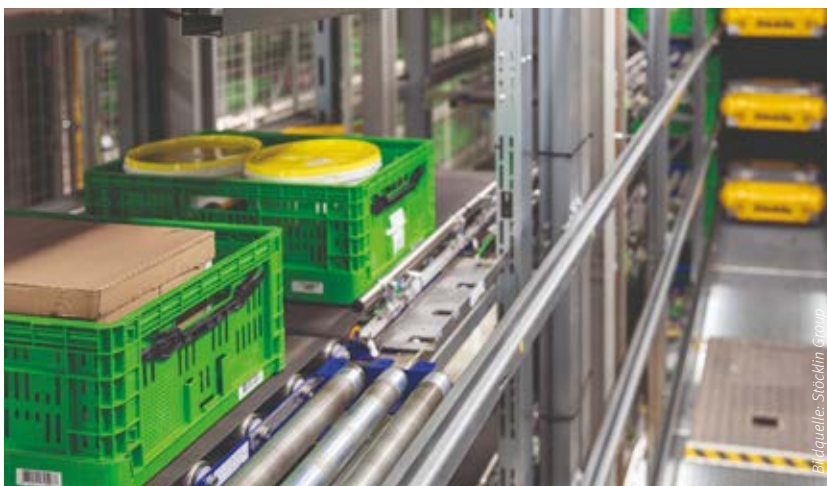
Die neue vollautomatische FSP Shuttle-Lagerlösung ist für das Handling von Frisch- und Trockenwaren bei 2 bis 5 °C ausgelegt.
