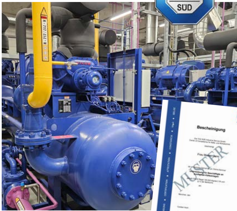
Ammoniak-Kälteanlage in einem Kühlhaus
