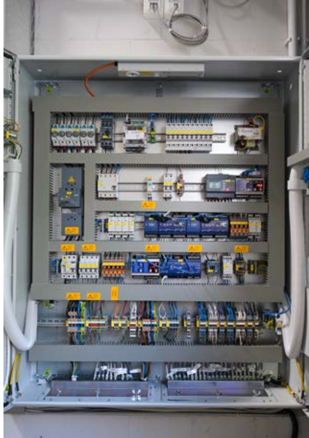
Der bei Willemsen verbaute Regelschrank ermöglicht eine bedienungsfreundliche Regelung der Daikin CO 2 -Zeas und der in den Kühlräumen verbauten Hochleistungsluftkühler.
