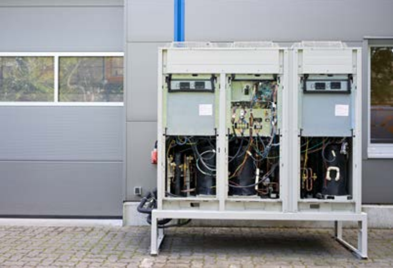
Daikins CO 2 -Zeas ist eine transkritische, invertergeregelte Kompakt-Verbundanlage für den polyvalenten Einsatz in der Normal- und Tiefkühlung.
