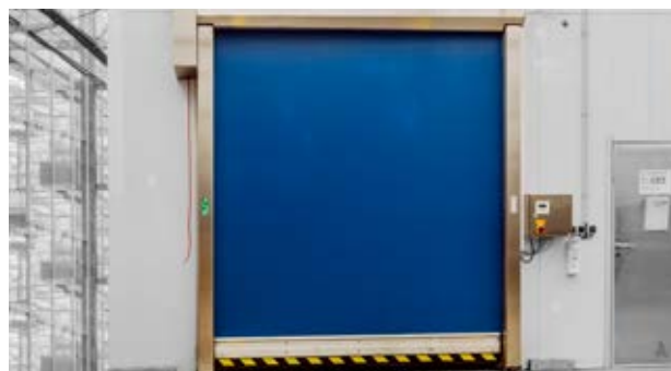
Im Keimraum kommt ein EFA-SRT EC mit Edelstahlzargen zum Einsatz.
