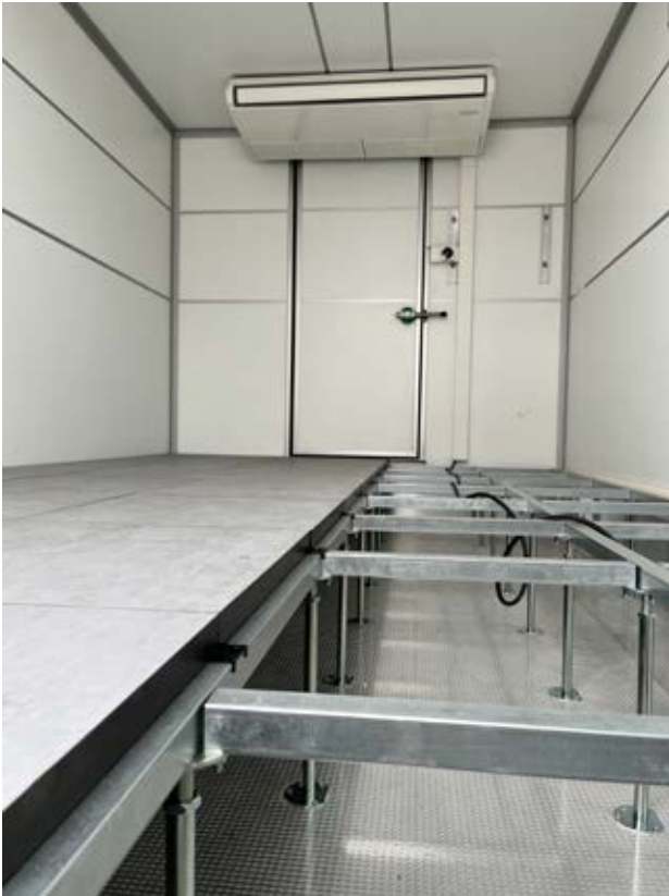
Die Leitungen der Stromspeicher werden im Doppelboden des Power House verlegt.
