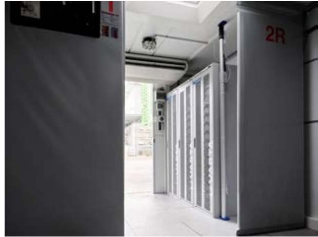
Das Power House bietet mit einem K-Wert von unter 0,4 \text{ W/m}^2\text{K} Stromspeichern einen klimatisierten Raum.
