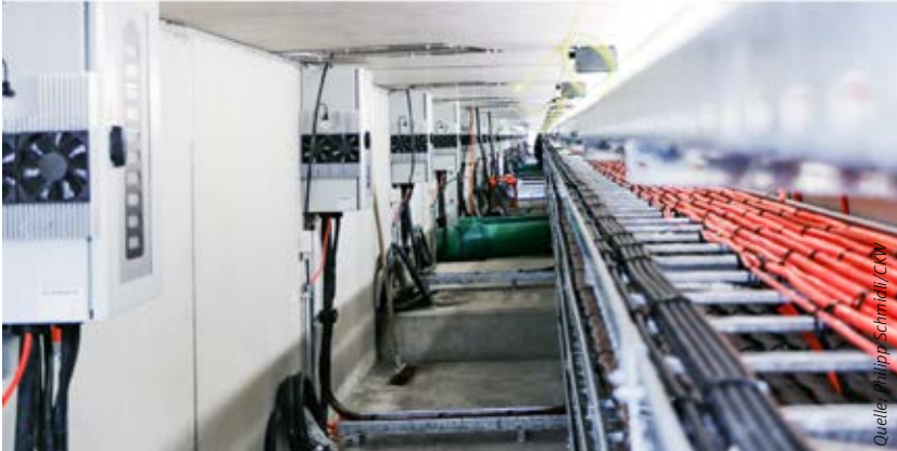
Die LKW-Ladetechnik befindet sich platzsparend im Untergrund des Parkplatzes.
