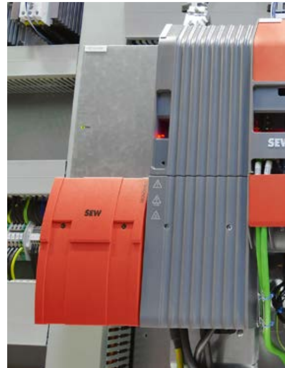
Zur Speisung der Motoren kommen Movidrive Doppelachsmodul (rechts) und ein Movidrive Versorgungsmodul (grau) aus dem Automatisierungsbaukasten Movi-C zum Einsatz.
