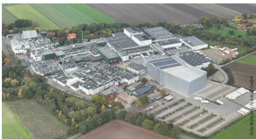
Die TK-Lager wurden bei Wernsing um 20 Grad gedreht an das Kühltager gesetzt, um auf der Bestandsfläche Kapazität für die verarbeitete Kartoffelernte einer ganzen Saison zu schaffen.
