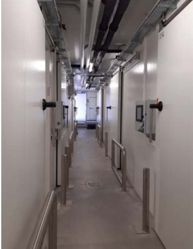
Die Räume für die Pilzzucht und anschließende Weiterverarbeitung errichtete das G+H Team in Paneelbauweise.
