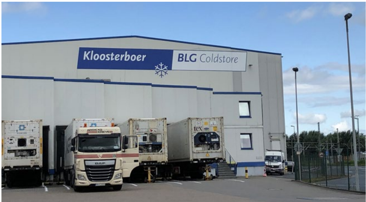
Andockbereich des Coldstore mit Kühlcontainern.
