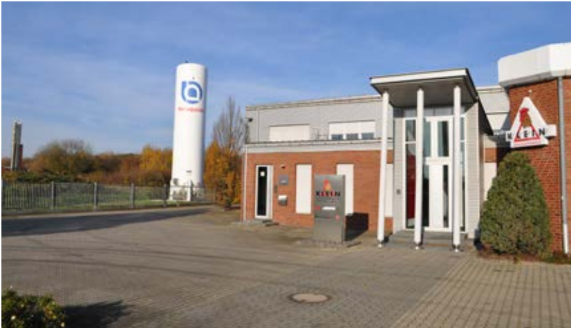
Bei Klein Geflügelfeinkost in Drensteinfurt setzt man auf die Technologie von Air Liquide.
