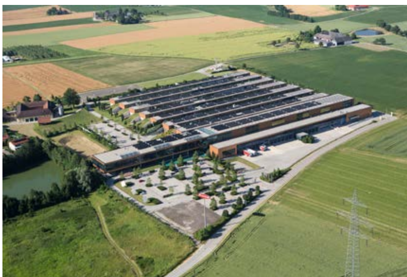
Auf dem Weg zur CO 2 -neutralen Intralogistik spielt der Einsatz erneuerbarer Energien eine große Rolle – und ganz besonders die Nutzung von Photovoltaik-Anlagen.
