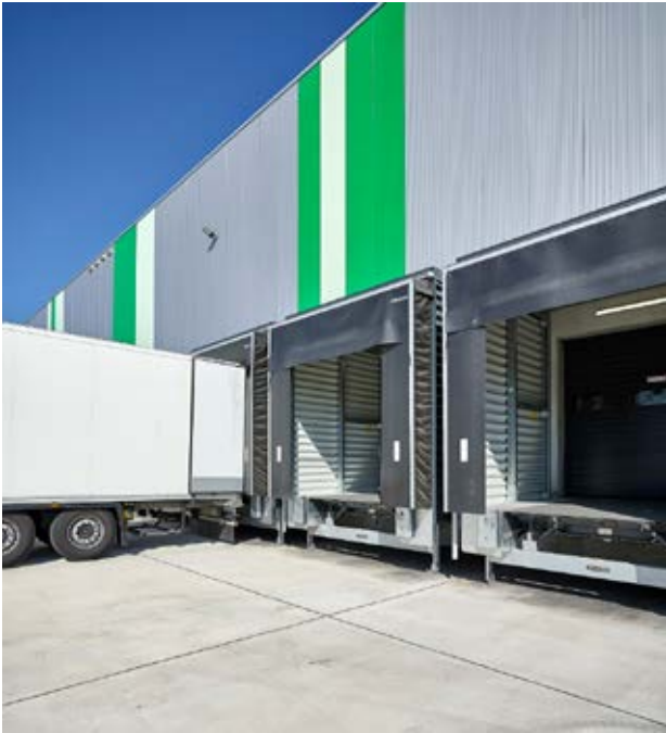
An den Hörmann Vorsatzschleusen im Kühlbereich wurden Planentorabdichtungen vom Typ DSL verbaut. Deren Lenkarmkonstruktion ist horizontal und vertikal flexibel.
