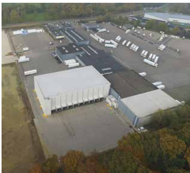
Blick auf das neue Frischelager von HSF in Winterswijk.
