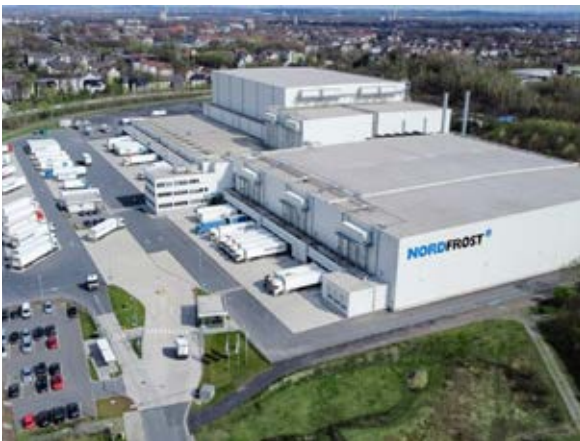
NORDFROST-Kühlhausstandort in Herne
