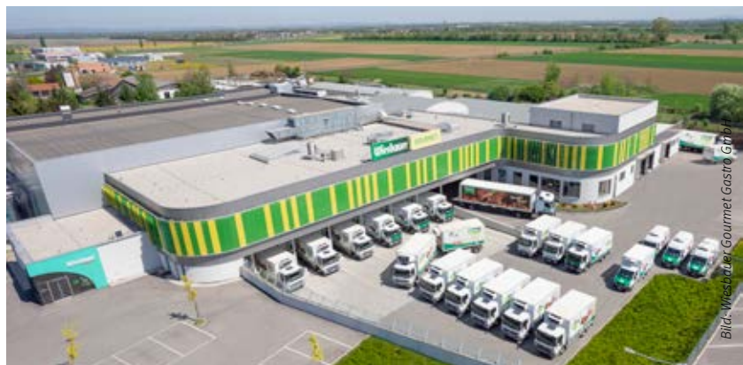
Ein neues dreigassiges Tiefkühlager soll bei Wiesbauer Prozesse effizienter gestalten und Personal entlasten.
